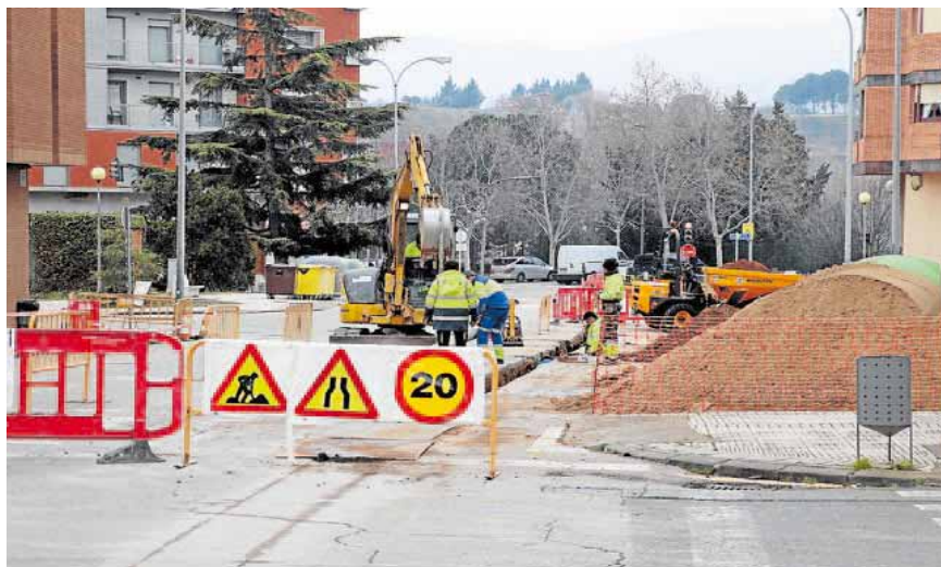
Los trabajos de apertura de la zanja comenzaron la pasada semana, permitiendo el tráfico por un carril. E. P.
