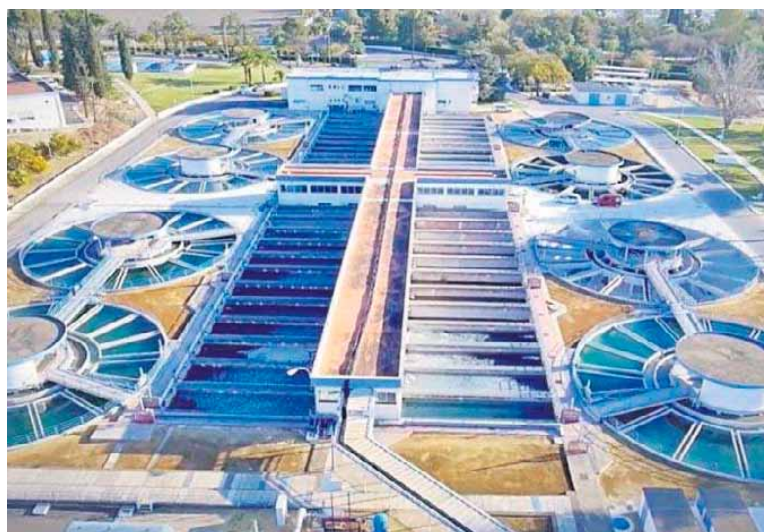
Planta potabilizadora del Carambolo.
